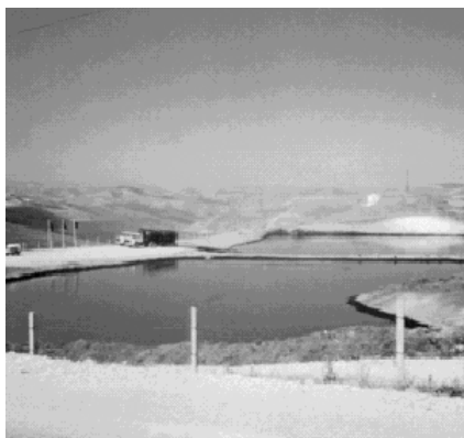
Fig. 3 : Bassin de traitements des eaux dans la région de Fès [Source : http://www.maroc-hebdo.press.ma/MHinternet/Archives342/PDF_342/Page27.pdf ]
